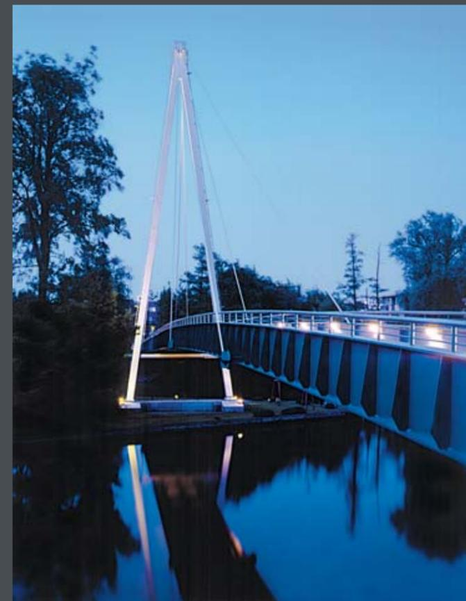
108 Meter lang, verbindet die Brücke seit Juli 2001 die Alte Spree und den südlichen Teil der Baumgarteninsel im Berliner Bezirk Köpenick. Im Fokus der Beleuchtung mit SILL Hochleistungsstrahlern der 491er Serie steht der 27 Meter hohe Pylon in der Mitte der Hängebrücke.
