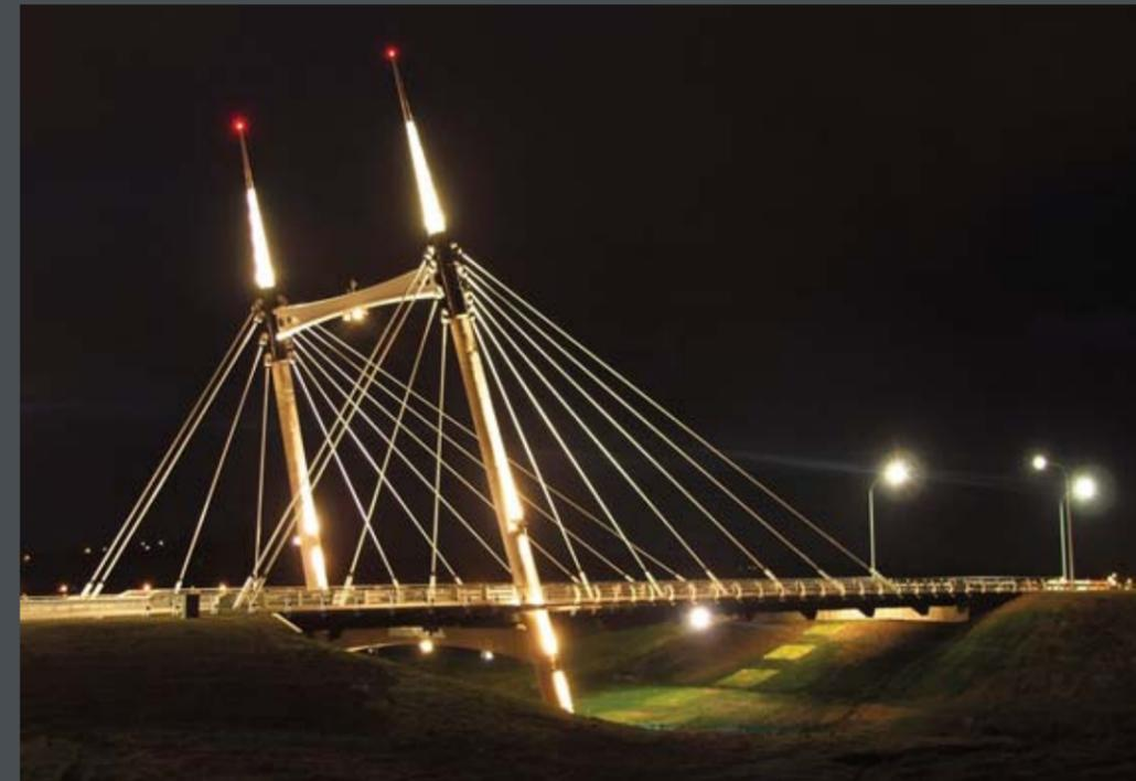
Fast 70 Kilometer Kabel halten die erste Schrägseilbrücke Neuseelands sicher über dem Otara Creek. Das nationale Wahrzeichen mit 70 Metern Länge und 27 Metern Breite bildet eine zentrale Zufahrt zum neuen Stadtzentrum. Obwohl erst im Oktober 2008 eröffnet, wurde die Beleuchtung – SILL Strahler der 021er-Serie und der 030er-Serie, bestückt mit 150 W bzw. 70 W Halogen-Metaldampflampen – bereits von der IES The Lighting Society mit dem Award of Excellence 2008 ausgezeichnet.
