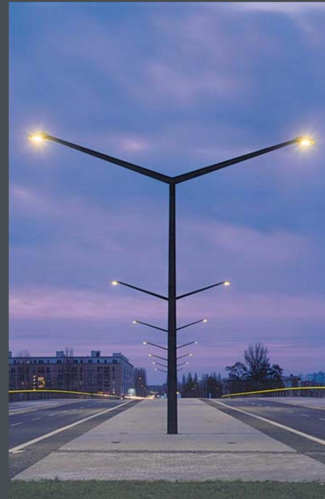
Die knapp 250 Meter lange Havelbrücke wird neben Lichtbändern entlang der Handläufe auf beiden Seiten durch Planflächenstrahler der 458er-Serie beleuchtet. Diese sind an zweiarmigen, minimalistischen Masten montiert und unterstreichen damit die Funktionalität der Brücke. Die Wasserstadt Oberhavel verfügt mit der 2001 fertiggestellten Brücke nun über eine direkte Verbindung zum anderen Havelufer.
